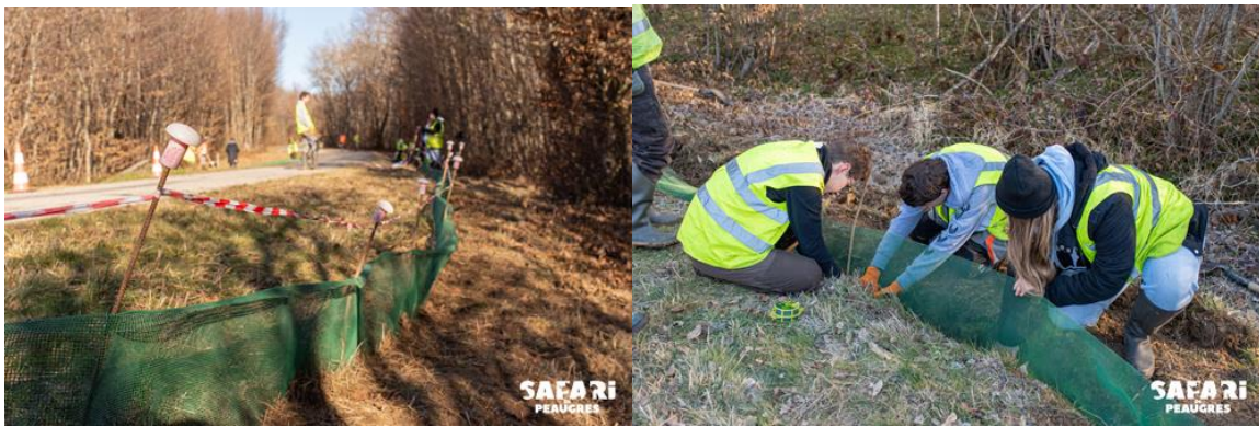
Figure : Mise en place de filet de protection pour les amphibiens (source : https://www.safari-peaugres.com/actualites/des-installations-pour-la-protection-des-amphibiens )
